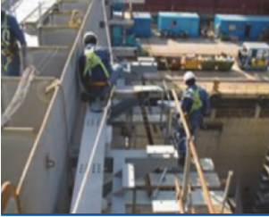
안전대부착설비 설치 및 안전대 착용
