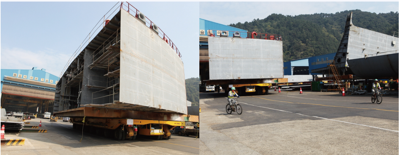
트랜스포터를 이용한 대형 블록 이송 작업
