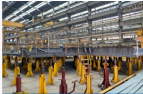
평블록 작업 전경
