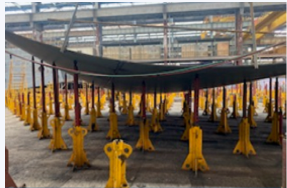
곡블록 작업 전경2
