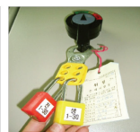
기동스위치 잠금장치 설치
