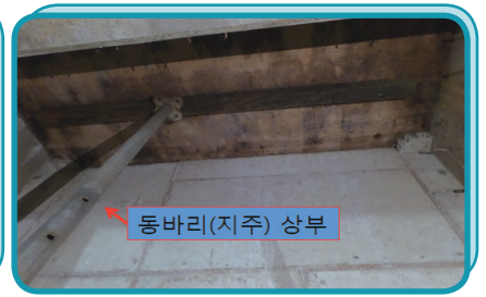
다른장소 합판하부 지주설치 상태
