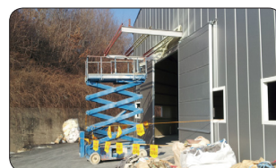
재해발생 현장 및 고소작업대
