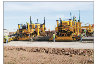
콘크리트 살포기 및 콘크리트 피니셔 조합작업
