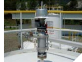
통기밸브와 역화방지 (Flame Arrester)
