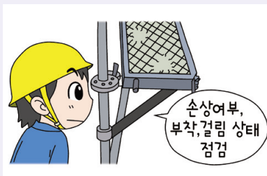
발판 재료의 손상 여부 및 부착 또는 걸림 상태
