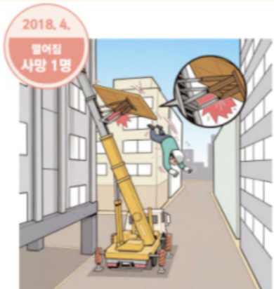
2018. 4. 떨어짐 사망 1명 이삿짐 운반구 각도조절 파이프 고정핀 체계 불량으로 운반구 기울어지면서 떨어짐
