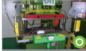
광전자식 방호장치 설치
