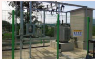
수변전 시설 방책 설치
