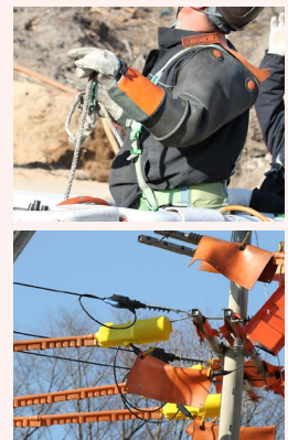
[절연용 방호구 착용 및 절연용 방호구 설치 사례]
