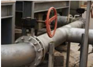
접합부 개스킷 설치
