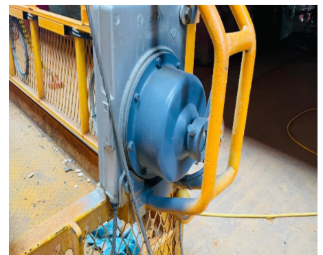
권상기 및 낙하방지장치 작동상태 확인
